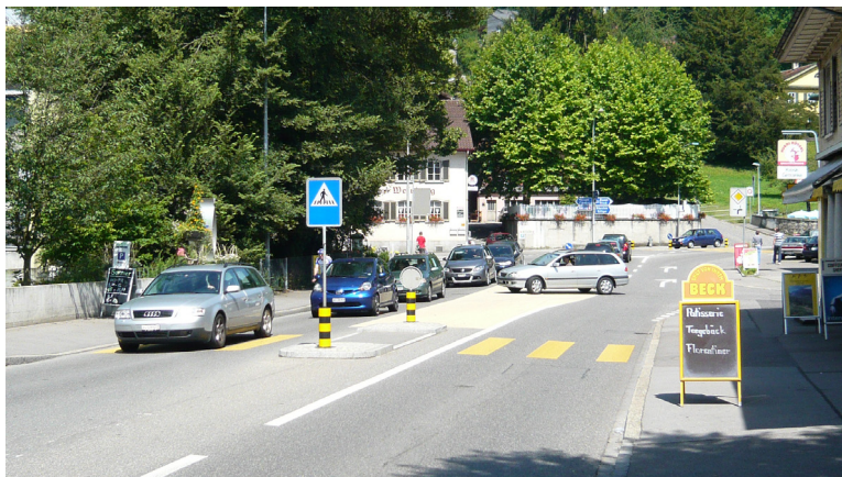
Voie centrale polyvalente permettant le tourné-à-gauche et la réinsertion en deux temps pour les voitures et bus, TJM 26'000 véh/j, fréquence des bus 10 minutes, carrefour Küttigerstrasse, Aarau (AR) (source : mrs)
