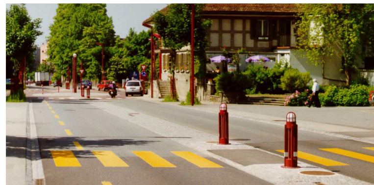
Passage piéton sécurisé avec îlot intégré à une bande médiane, à Zollikofen (BE)
